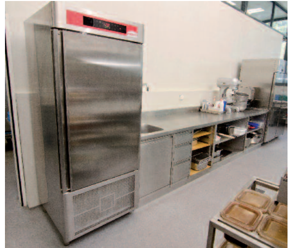
Der Schnellkühler/Schockfroster FrigoJet der Hugentobler AG ist ein wichtiger Bestandteil der neuen Küche: Dank dem FrigoJet konnte das Banketting- und Catering-Business überhaupt realisiert werden.
